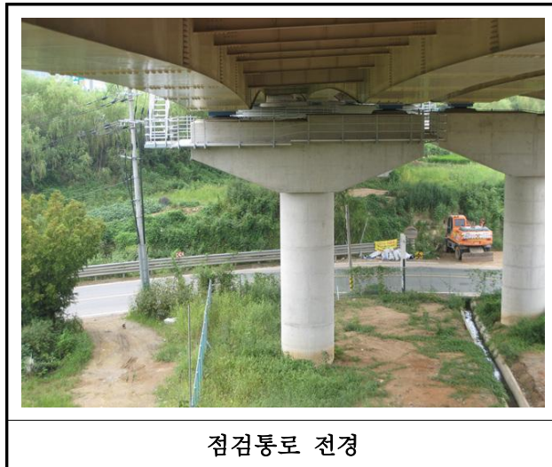
【사진 4.3.25】 교량 점검시설 전경
