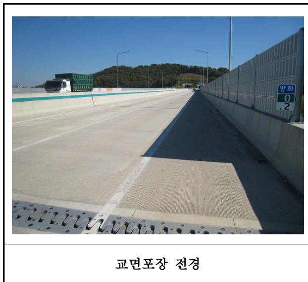
【사진 4.3.19】 교면포장 전경
