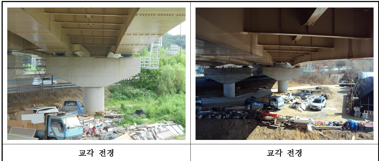
【사진 4.3.10】 교각 전경
