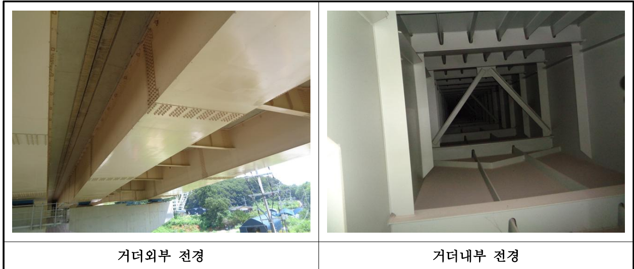
【사진 4.3.4】 거더 전경
