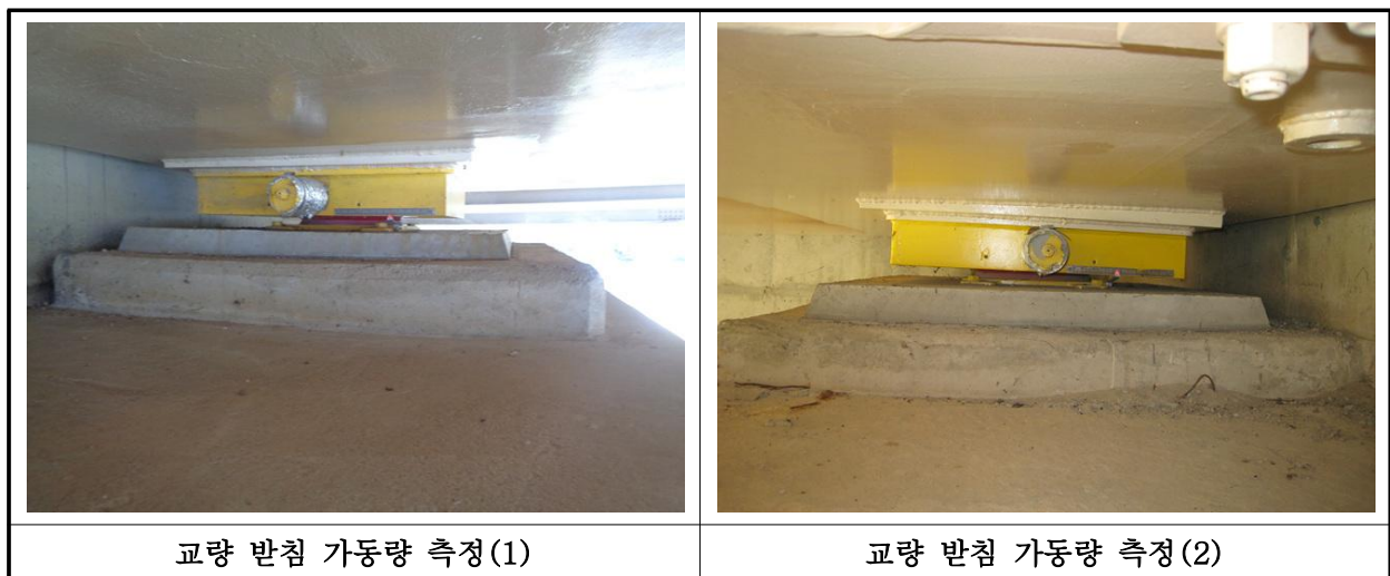
【사진 4.3.15】교량받침 이동량 측정
