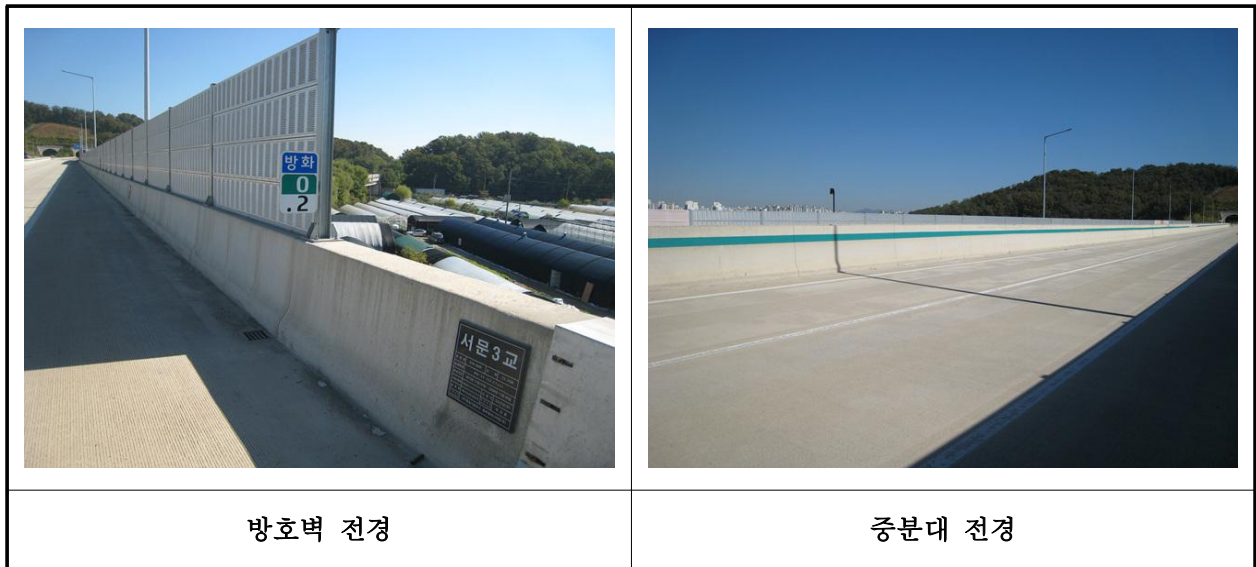
【사진 4.3.23】 방호벽 및 중앙분리대 전경
