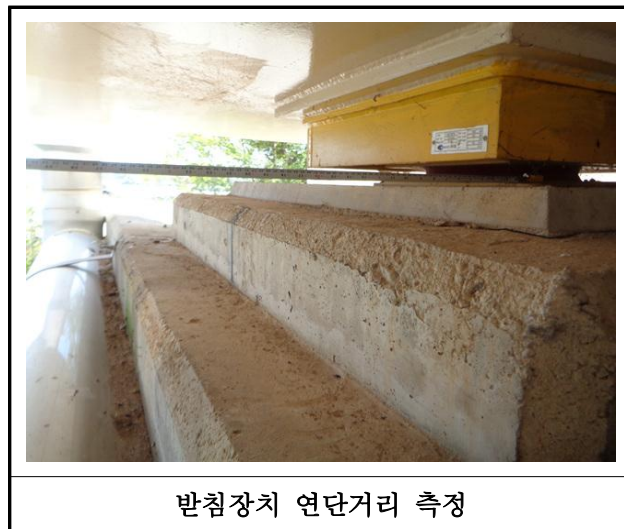
【사진 4.3.14】 교량받침장치 연단거리측정
