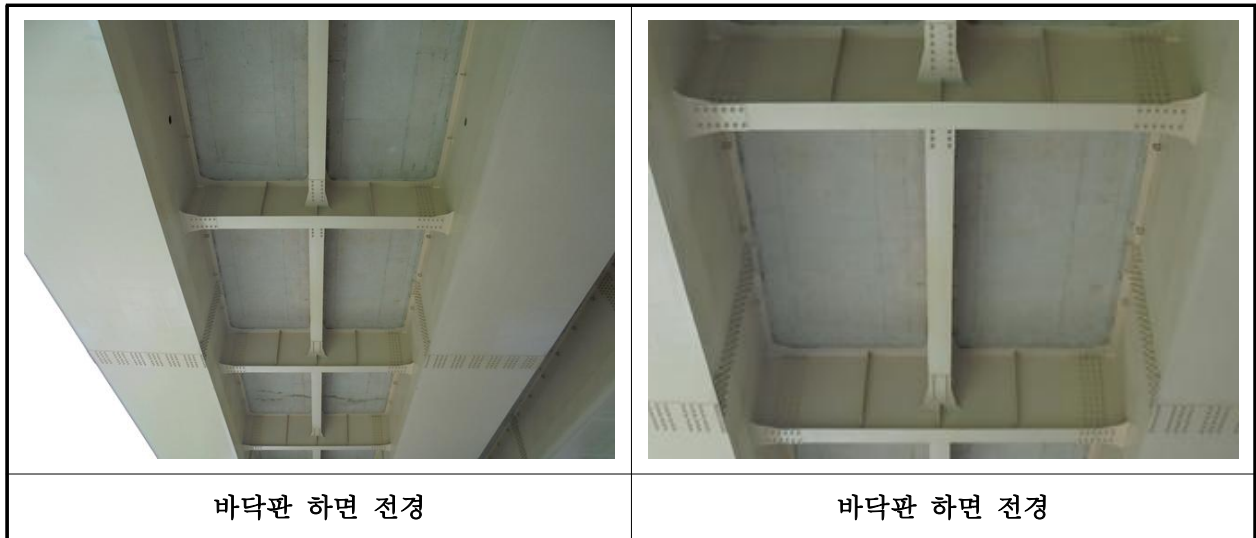
【사진 4.3.2】 바닥판하면 전경
