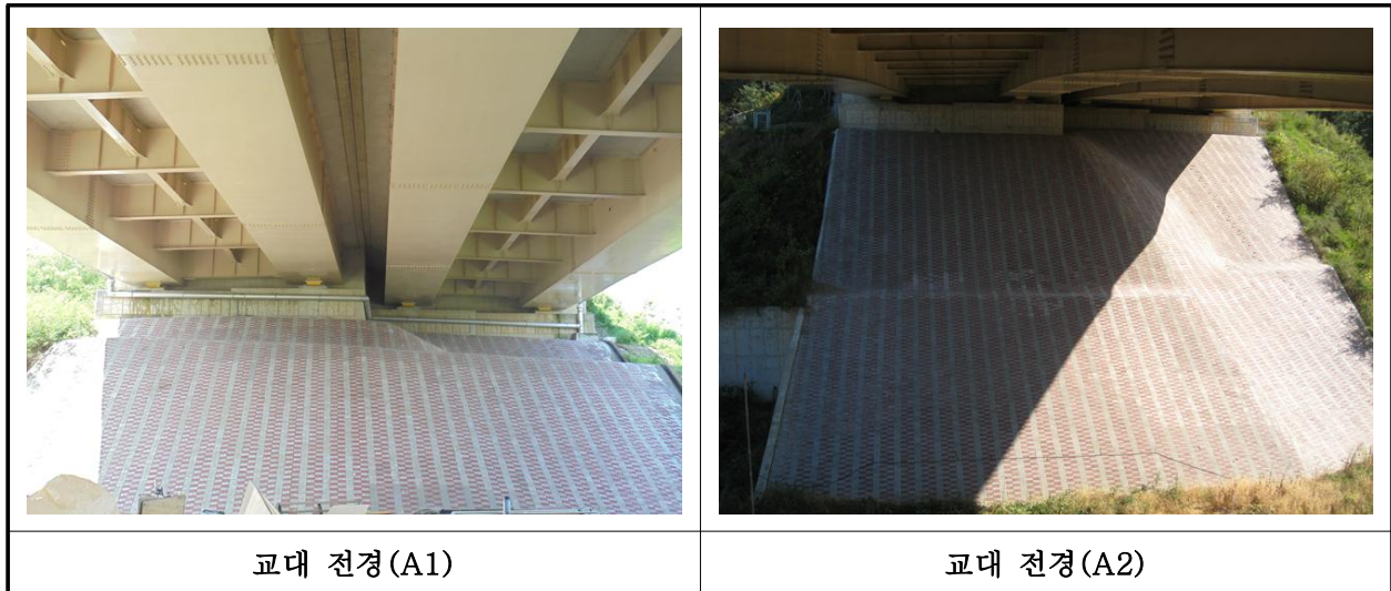
【사진 4.3.8】 교대 전경
