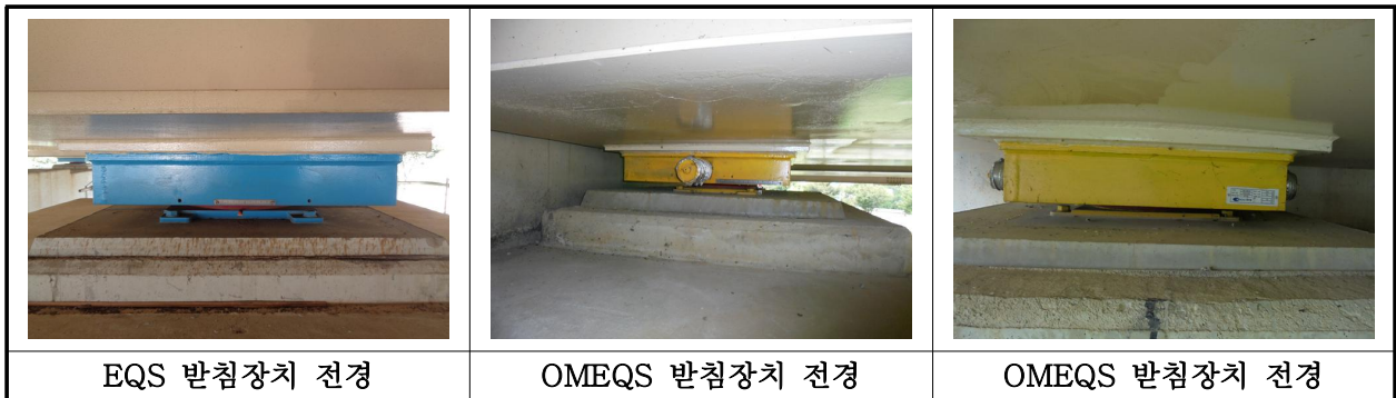
【사진 4.3.12】 교량받침 전경
