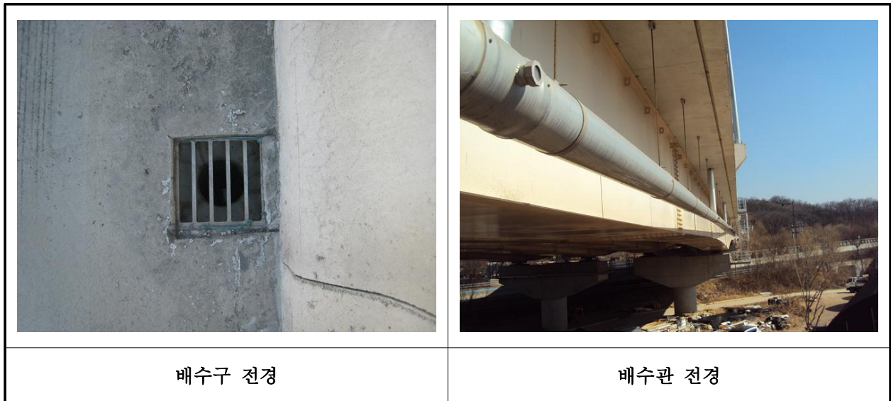
【사진 4.3.21】 배수시설 전경
