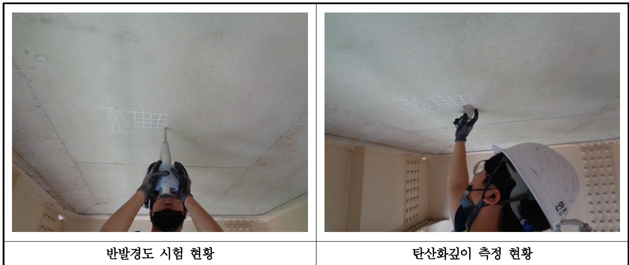
【사진 4.4.1】 콘크리트 내구성조사 현황
